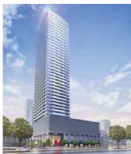
再建後の御園座イメージ 「『(仮称)栄一丁目御園座共同ビル計画』 建設事業に係る環境影響評価書」(名古屋市)より
